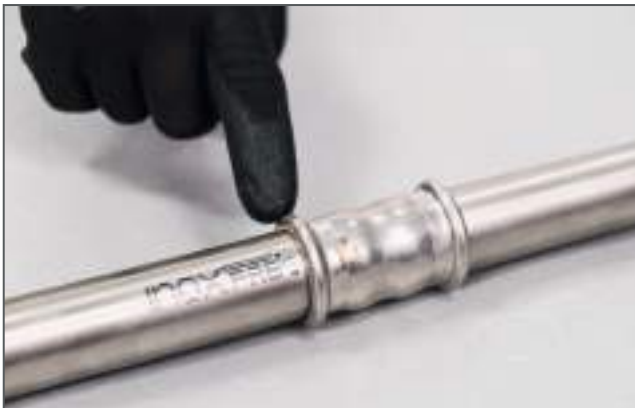
Controllo della pressatura / Checking the press connection
